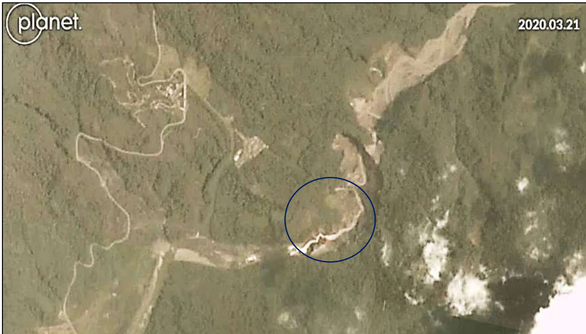
Foto 5 Inicio de la erosión regresiva en el lecho y los taludes del río Coca, con deslizamientos en los 2 márgenes y profundización del lecho del río debidos a baja cohesión de los materiales aluviales y piroclastos, alta pendiente del fondo y caudales voluminosos y rápidos. Escala aproximada E = 1/20.000 Fuente de la imagen: www. Planet.com/stories
