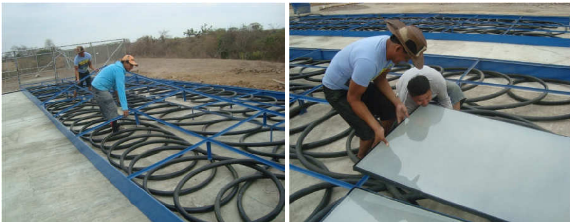
Colocación de sistema de soportes metálicos y paneles traslúcidos para captación del calor.
