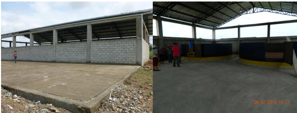
Infraestructura con que cuenta la Red de Mujeres Montubias Suave Brisa para secar el maíz, extendiéndolo en tendales o utilizando gas licuado de petróleo (GLP).
