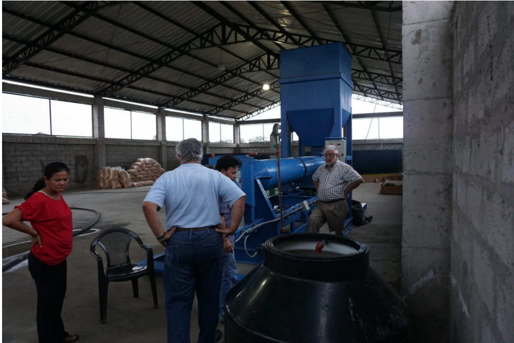
Personal técnico de CIE confirmando funcionamiento del sistema de transferencia de calor previo a la operación.
