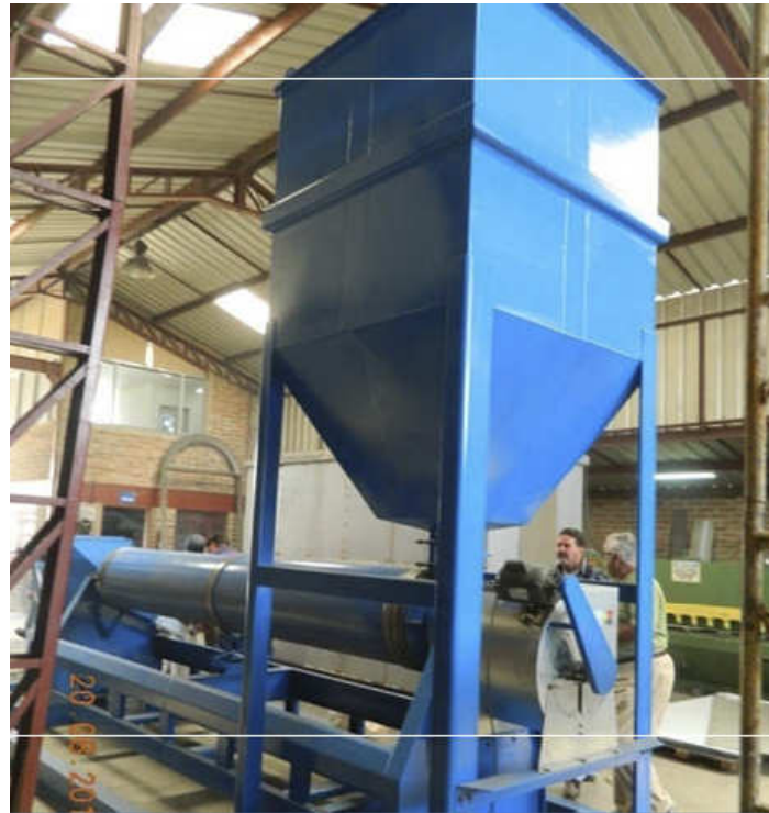
Conexión y pruebas del sistema eléctrico de la planta.
