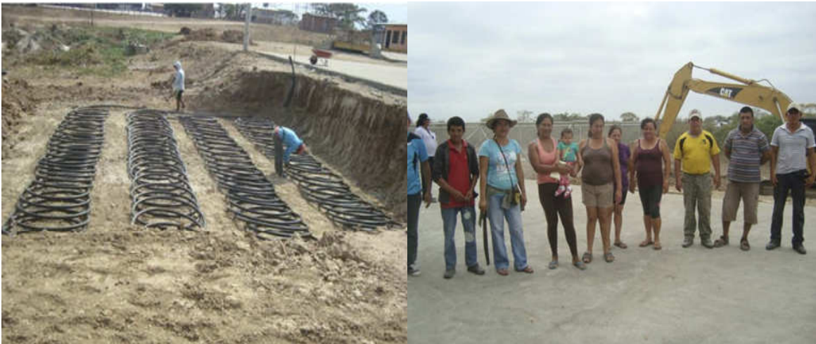
Instalación del sistema de almacenamiento de calor.
